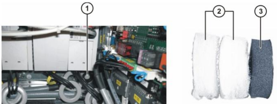
10-19: 更换压力平衡封隔器
